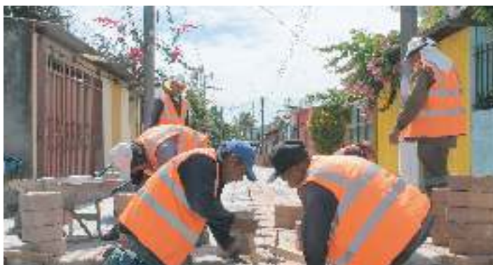
Segunda etapa de reconstrucción de acera y adoquinado en Pje. E-E, Jardines de la Hacienda
