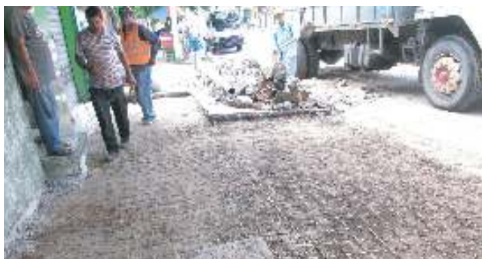
Reparación de acera en Casco Urbano
