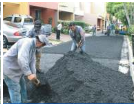
Recarpeteo en Residencial Pueblo Bonito sobre calle circunvalación
