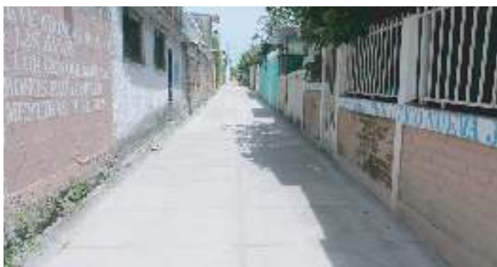
Reparación de pasaje 9 y 10 Jardines de la Hacienda
