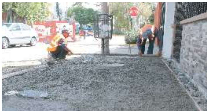
Reparación de aceras en Casco Urbano de Antigua Cuscatlán
