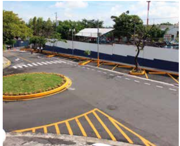
AMPLIACIÓN DE ESTACIONAMIENTO VEHICULAR, 3a. AVENIDA NORTE CONTIGUO A INSTITUTO NACIONAL DE ANTIGUO CUSCATLÁN
