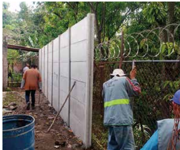
INSTALACIÓN DE TAPIAL PREFABRICADO, EN JARDINES DE LA HACIENDA 5° ETAPA
