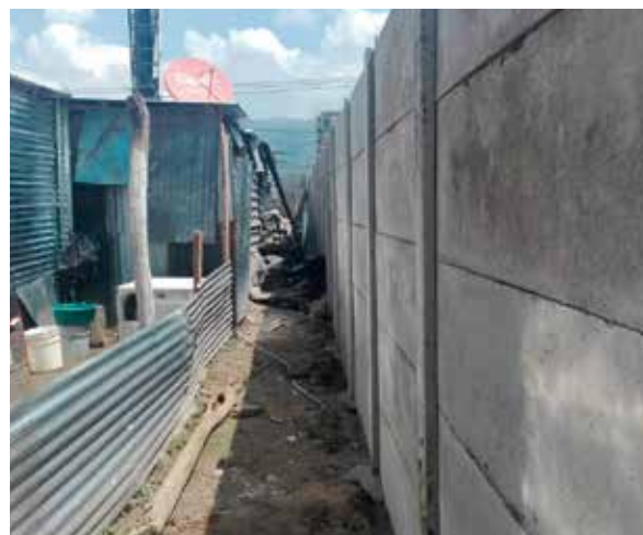
COLOCACIÓN DE TAPIAL EN PREDIO BALDIO FRENTE A CENTRO COMERCIAL LAS CASCADAS
