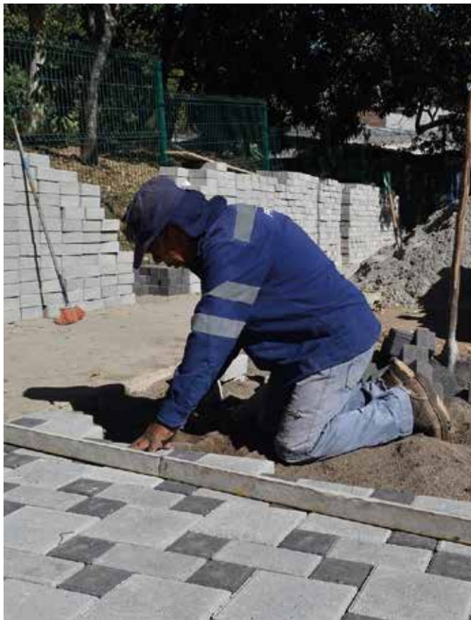
RECONSTRUCCIÓN DE 1,500MTS. DE ACERAS EN AV. RIO AMAZONAS
