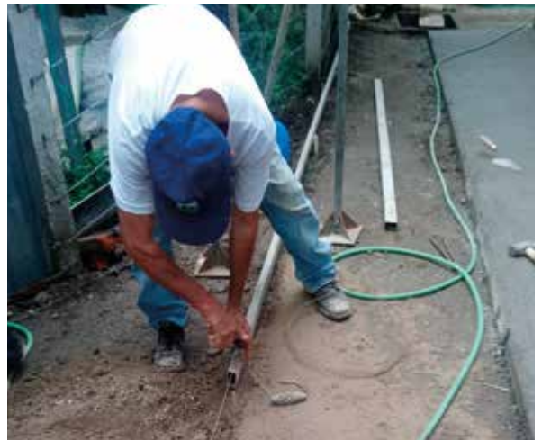
CONSTRUCCIÓN DE 54ml DE ACERA, EN COMUNIDAD EL TANQUE
