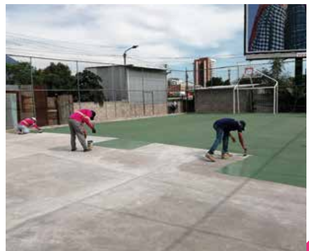
COLOCACIÓN DE CONCRETO EN CANCHA DE COMUNIDAD EL TANQUE
